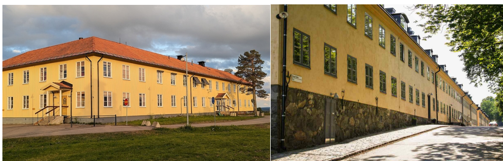
Figur 7. Referensbilder: Till vänster: Jägarskolan i Kiruna byggd 1945. Till höger: Långa raden på Skeppsholmen, byggd 1702.
